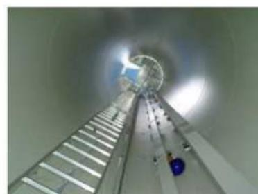
Son rôle est d'une part de supporter l'ensemble rotor + nacelle pour éviter que les pales ne touchent le sol, mais aussi de placer le rotor à une hauteur suffisante, de manière à sortir autant que possible le rotor du gradient de vent qui existe à proximité du sol, améliorant ainsi la captation de l'énergie. Dimensions : plus de 80 m de haut et un diamètre supérieur à 10m.
